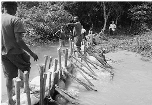
写真-1 小河川に木材、土嚢、石でつくった堰
